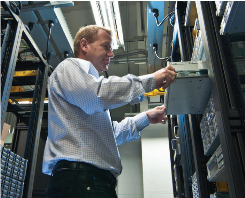
Ambiente de pasillo caliente/ pasillo frío con 5 kW por gabinete
