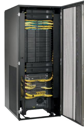
Evite los gabinetes con un ancho menor a 32." CISCO requiere de seis pulgadas libres entre los lados de los interruptores de la Serie 6500 y las paredes del gabinete.
