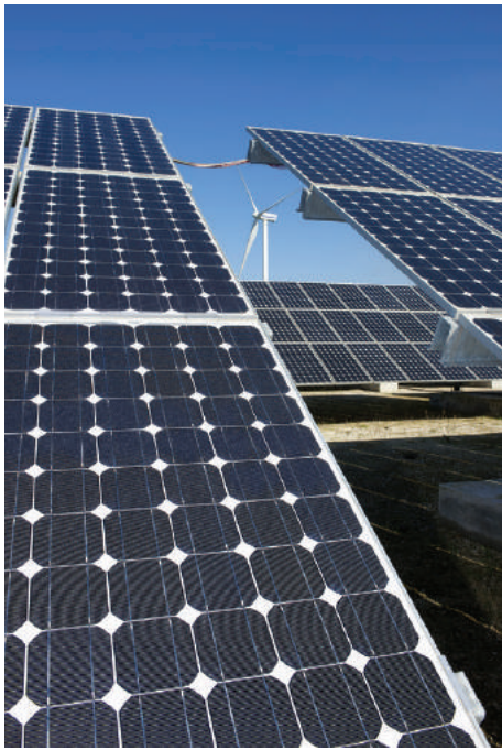
Con el objetivo de asegurar la operación continua del equipo crítico electrónico y de red en aplicaciones solares, los diseñadores deben elegir los gabinetes eléctricos ideales que contribuyan con los sistemas helio térmicos y de seguimiento solar.
