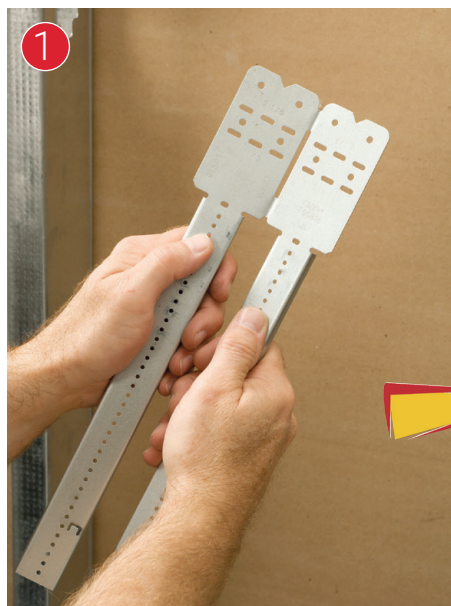
1. Ouvrir la fixation TSGB aux point de pliure.
