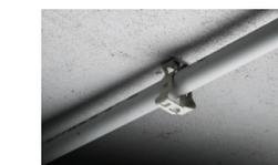
Kabelschutzrohr auf Beton
