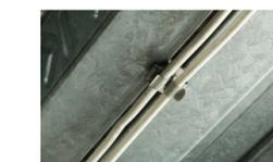
Kabel und Kabelschutzrohre abgehängt von Metalldecken
