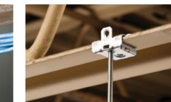
Gewindestange/Kette/Draht abgehängt von Trägern
