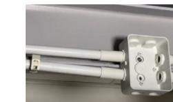
Kabelschutzrohre und Verteilerdosen abgehängt von Trägern
