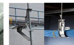
Kabel abgehängt von Gewindestangen
