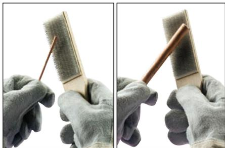
**Fig. 5** – Fatto ciò, utilizzare una spazzola metallica per preparare ulteriormente la superficie dei conduttori e il picchetto di terra (spazzola Cadweld T-313 o T-314).
