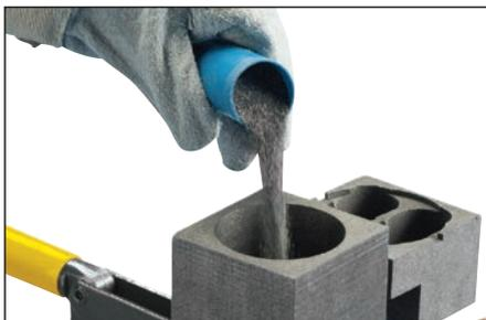
**Fig. 20** – Versare rapidamente la polvere del materiale per saldatura nello stampo.
