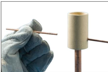
**Fig. 7** – Inserire i conduttori e posizzarli per la connessione.
