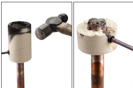
**Fig. 15** – Staccare lo stampo in ceramica Cadweld One Shot dalla connessione. Evitare il contatto con materiali caldi. Per verificare se è stata effettuata una connessione di qualità, consultare la sezione “Standard di qualità nVent ERICO Cadweld”.
