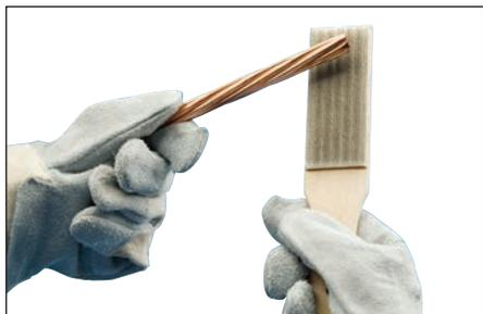
**Fig. 12** – Fatto ciò, utilizzare una spazzola metallica per preparare ulteriormente la superficie dei conduttori e il picchetto di terra (spazzola nVent ERICO T-313 o T-314). Raschiare la superficie esterna per rimuovere sporco e ossidazione.
