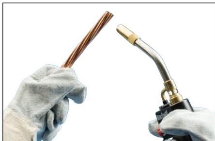
**Fig. 11** – Prima di effettuare la connessione, i conduttori devono essere puliti e asciutti. Prima di effettuare la connessione Cadweld, utilizzare un cannello a propano per asciugare i conduttori metallici e rimuovere eventuali residui di pulizia, solvente o acqua.
