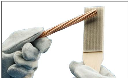
**Fig. 12** – Fatto ciò, utilizzare una spazzola metallica per preparare ulteriormente la superficie dei conduttori (spazzola nVent ERICO T-313 o T-314). Raschiare la superficie esterna per rimuovere sporco e ossidazione. Questa operazione può causare un leggero cambiamento di colore.
