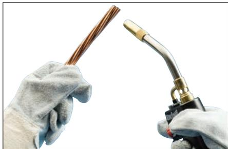
**Fig. 11** – Prima di effettuare la connessione, i conduttori devono essere puliti e asciutti. Prima di effettuare la connessione Cadweld, utilizzare una torcia a propano per asciugare i conduttori metallici e rimuovere eventuali residui di pulizia, solvente o acqua.
