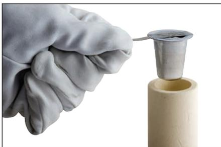
**Fig. 9** – Posizionare la coppa del materiale per saldatura nella parte superiore dello stampo. Verificare che la striscia di accensione sia inserita nella rientranza presente sul bordo superiore.
