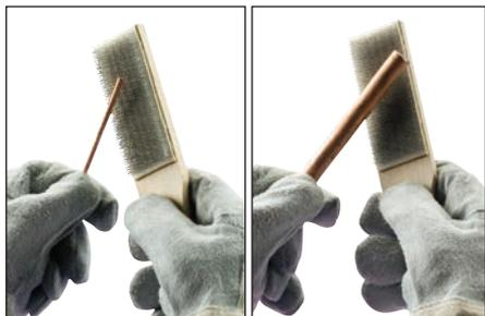
**Fig. 5** – Fatto ciò, utilizzare una spazzola metallica per preparare ulteriormente la superficie dei conduttori e il picchetto di terra (spazzola nVent ERICO T-313 o T-314).
