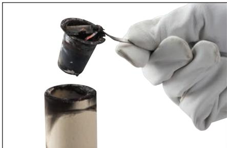
**Fig. 14** – Rimuovere e smaltire la coppa di saldatura usata Cadweld Plus.
