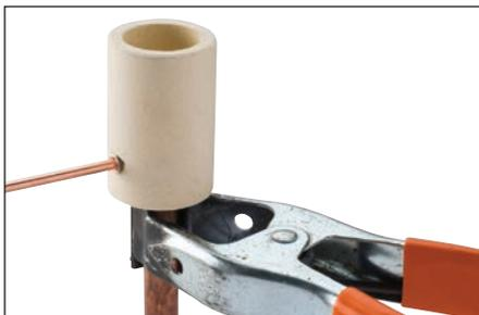
**Fig. 7** – Inserire i conduttori e posizionarli per la connessione.
