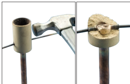
Fig. 16 – Déconnectez le moule Cadweld One Shot en céramique de la connexion. Éviter tout contact avec des matériaux chauds. Voir la section « Normes de qualité nVent ERICO Cadweld » pour voir si une connexion de qualité a été établie.
