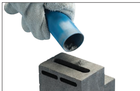
Fig. 23 – Fermer le couvercle et verser les \frac{1}{4} à \frac{2}{3} restants du matériau de démarrage dans la fente du couvercle du moule.
