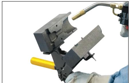
**图 10** - 石墨吸收水分。点燃丙烷喷灯，彻底干燥模具内部两侧，将模具加热至约 250 华氏度（120 摄氏度）。
