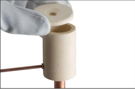
图 12 - 将盖子放在 Cadweld 一次性套件的顶部。
