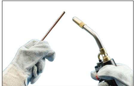
**图 4** – 联接前，导体应清洁干燥。在进行 Cadweld 联接前，使用丙烷喷灯干燥电线导体，清除残留的清洁残留物、溶剂或水。
