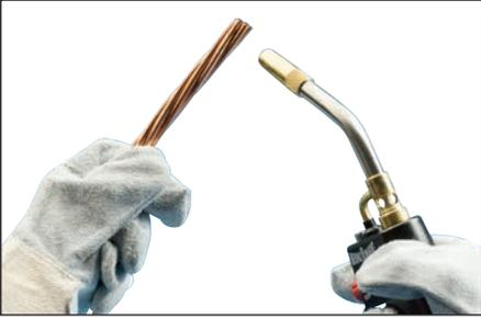
**图 11** - 联接前，导体应清洁干燥。在进行 Cadweld 联接前，使用丙烷喷灯干燥电线导体，清除残留的清洁残留物、溶剂或水。
