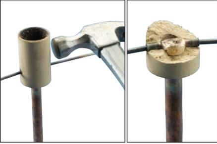
**图 16** - 将陶瓷 Cadweld 一次性套件模具与联接件断开。避免接触热材料。参见“盈凡艾力高 nVent ERICO Cadweld 质量标准”部分，了解是否已实现合格联接。
