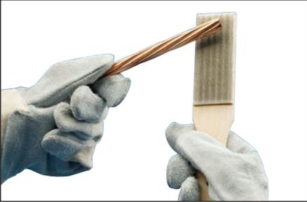
**图 12** - 接下来，用钢丝刷进一步处理导体表面和接地棒（盈凡艾力高nVent ERICO T313 或 T314 钢刷）。刮擦外表面，以清除污垢和氧化层。您会发现颜色稍有变化。
