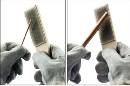
**图 5** - 接下来, 用钢丝刷进一步处理导体表面和接地棒 (盈凡艾力高nVent ERICO T313 或 T314 钢刷)。
