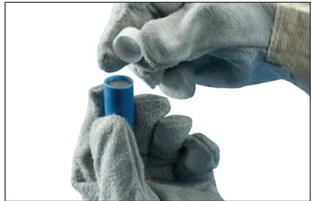
**图 10** - 接下来, 从 Cadweld 一次性套件材料包中取出一管焊药, 取下焊药管上的盖子。
