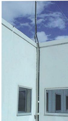
Ericore 绝缘屏蔽引下线可轻松在现有建筑物上改装。插图：安装在系统 3000 上的 盈凡艾力高 雷电计数器 (LEC V)，用于记录雷击次数。
